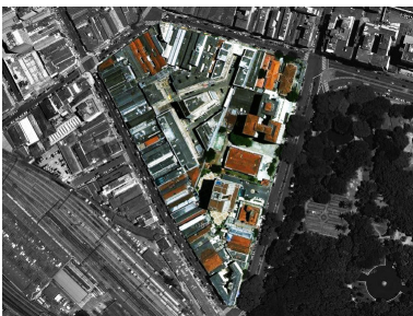
Centro Comercial Bom Retiro
