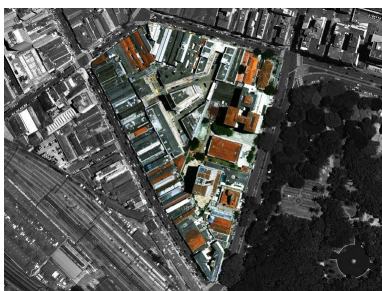
Centro Comercial Bom Retiro
